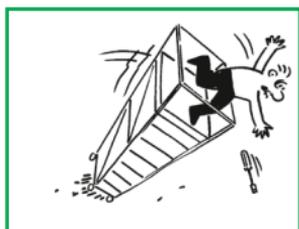
Das **Umherstossen** mit Personen auf dem Gerüst ist strikt untersagt. Das Gerüst darf nur manuell an der Basis verschoben werden. Die Ausleger werden für das Umherstossen etwas gelöst und max. auf 25 mm angehoben.
